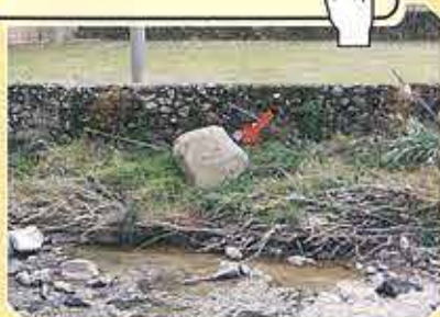
写真(1) 福岡県朝倉市
